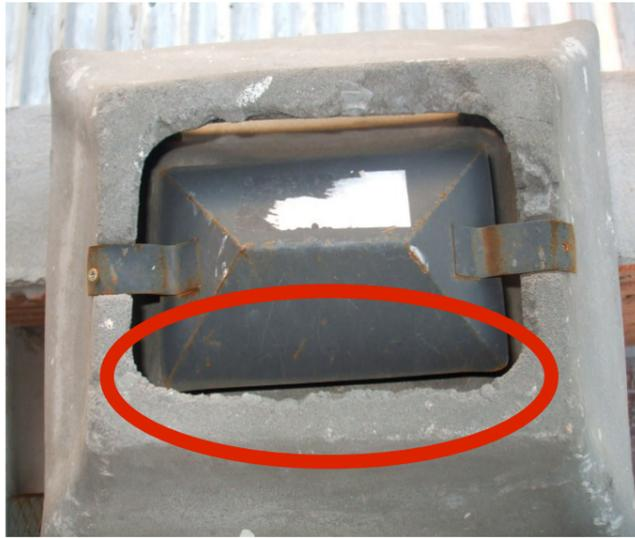
CUÑA DECENTRADA CON EL ELEMENTO INFERIOR – UN FALDON DESAGUA DENTRO DEL CONDUCTO.
