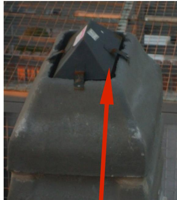
CUÑA SOBREELEVADA – EL AGUA DE LLUVIA DEBE RECORRER MAS DE LO DEBIDO HASTA ALCANZAR EL FALDON DEL ELEMENTO INFERIOR INTRODUCIENDOSE POR INFLUENCIA DEL VIENTO DENTRO DEL CONDUCTO
